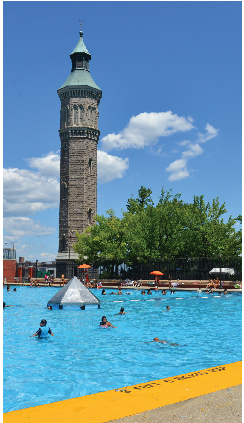
Torre de agua y piscina de Highbridge
